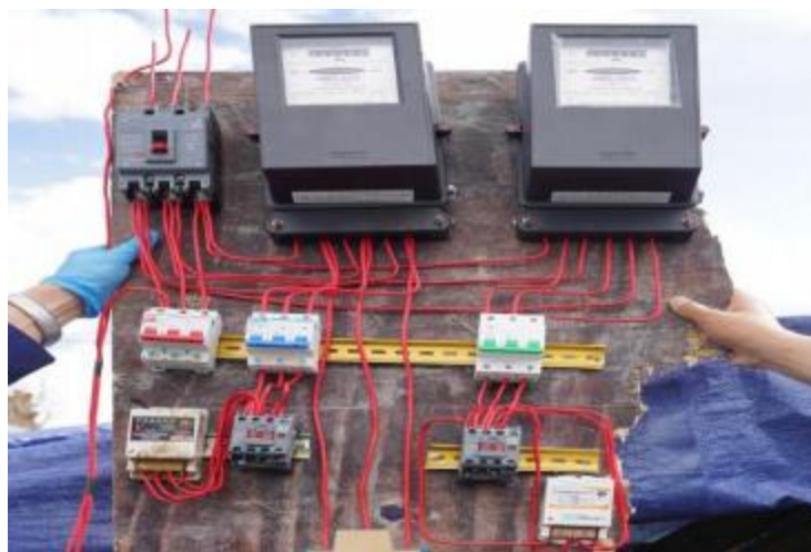
图 5 木制配电盘复原图
